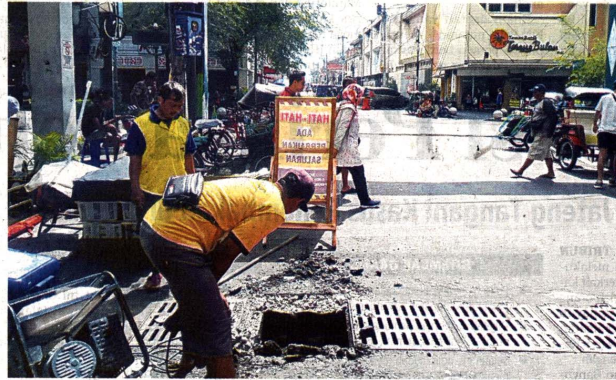
ISTIMEWIA/DOK. DINAS PUPKP KOTA YOGYA PEMBERSIHAN - Petugas Dinas PUPKP melakukan pembersihan salah satu titik drainase di Kota Yogyakarta. Pemkot Yogyakarta mengupayakan perawatan dan pemantauan drainase saat peningkatan curah hujan.
