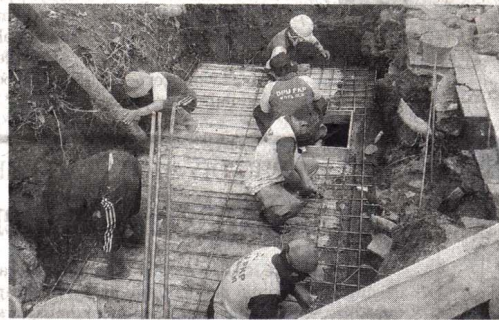
MERAPI-DOKUMEN PEMKOT YOGYAKARTA Petugas DPUPKP Kota Yogyakarta melakukan perbaikan drainase di Jalan Kol Sugiono.
