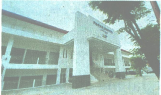
BANGUNAN BARU - Bangunan baru Pasar Sentul, Kota Yogyakarta, yang rampung direvitalisasi per akhir 2023 lalu. Pedagang rencananya akan direlokasi pada bulan Februari atau setelah Pemilu.
