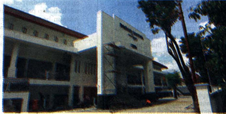
PASAR MODERN: Pasar Sentul setelah direvitalisasi Dinas PUPKP Kota Yogyakarta. Pasar Sentul nantinya akan menggabungkan konsep pasar tradisional dan pasar kuliner.
