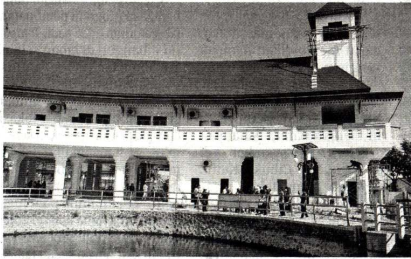
Proyek pembangunan gerbang masuk Taman Budaya Embung Giwangan yang bergaya Indis, seperti terlihat belum lama ini.
