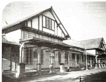
Tampak depan bangunan SDN Ngupasan.
