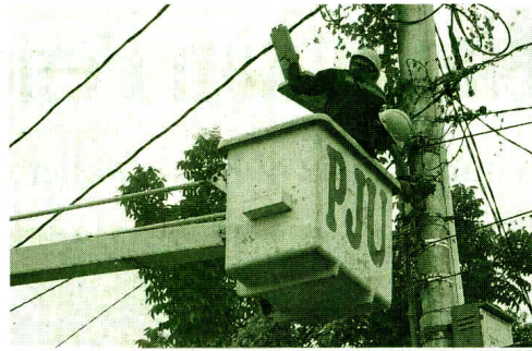
Petugas memasang lampu LED di tiang PJU Jalan Juwadi Kotabaru Yogyakarta.
