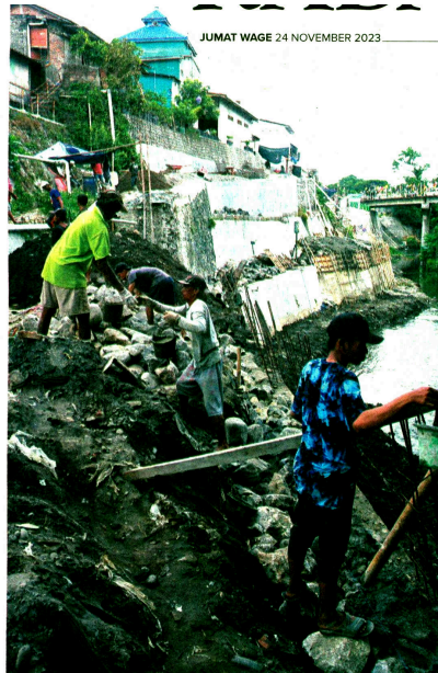
ANTISIPASI: Pekerja menyelesaikan proses pembangunan talud Sungai Winongo di wilayah Kelurahan Pringgokusuman, Kecamatan Gedongtengen, Kota Jogja, kemarin (23/11). Sebagai antisipasi bencana alam seperti banjir ataupun tanah longsor, talud sungai serta drainase menjadi perhatian utama Pemkot Jogja.
