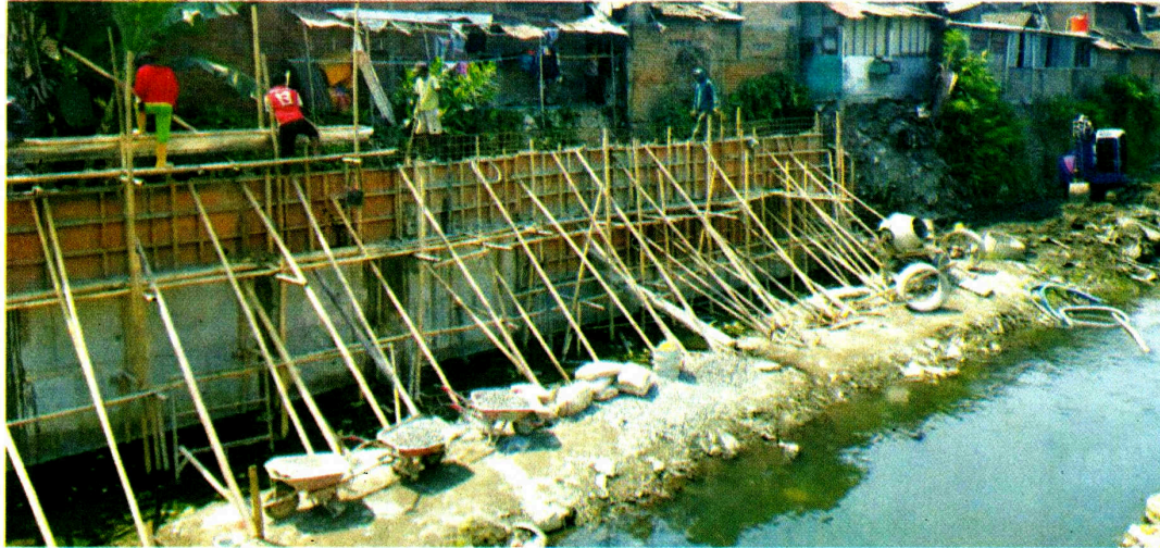
GARAP: Para pekerja saat mengerjakan tanggul sungai di Kota Yogyakarta, belum lama ini.
