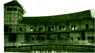
MEGAH: Nampak para pekerja saat mengerjakan pembangunan entrance atau gerbang masuk Taman Budaya Embung Giwangan Yogyakarta, belum lama ini.
