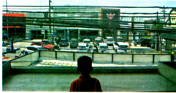
TAK TERTATA: Kondisi semrawutnya kabel fiber di kawasan Jalan Kaliurang, Sleman. Kondisi serupa juga terlihat di sejumlah ruas jalan di Kota Jogja seperti daerah Pingit, sekitar Stasiun Tugu dan Maliboro.
