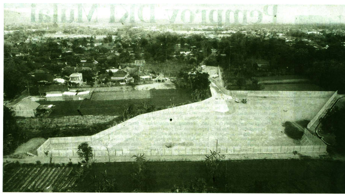
Pembangunan Tempat Pengolahan Sampah Terpadu (TPST) Tamanmartani di Desa Tamanmartani, Kalasan, Sleman, DI Yogyakarta, terus berlangsung. Senin (7/8/2023). TPST dengan luas sekitar 1,1 hektar itu ditargetkan bisa beroperasi pada Januari 2024. Adapun volume sampah yang bisa dikelola TPST itu 80-90 ton per hari.
