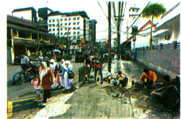
CEGAH PARKIR LIAR: Pekerja menyelesaikan pemasangan patok pembatas di pedestrian Jalan Pasar Kembang, Kota Jogja (5/7).
