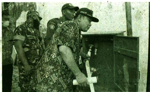
MERAPI-DISKOMINFOSAN KOTA YOGYAKARTA Kegiatan uji operasional hidran kampung yang dibangun di Kampung Notoprajan.
