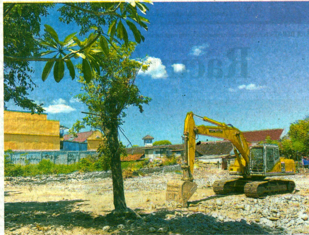
PEMBERSIHAN LAHAN - Sebuah alat berat tengah meratakan lahan Pasar Sentul, Pakualaman, Kota Yogya, yang siap dibangun bangunan baru, Jumat (9/6) siang. Proyek revitalisasi akan dilaksanakan bulan ini.
