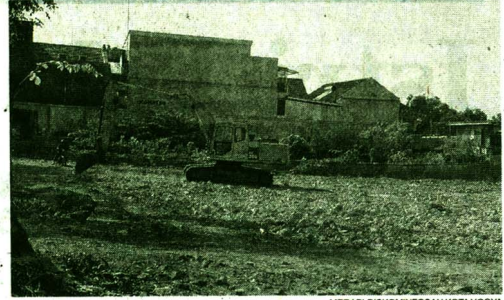
Lokasi bekas bangunan Pasar Sentul telah dirobohkan dan dilakukan pembersihan.
