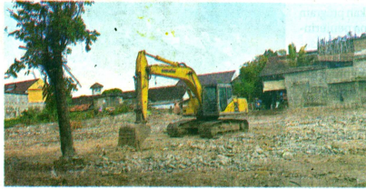
PERSIAPAN LAHAN: Alat berat sudah mulai membersihkan lahan yang akan digunakan untuk revitalisasi Pasar Sentul kemarin (5/6).
