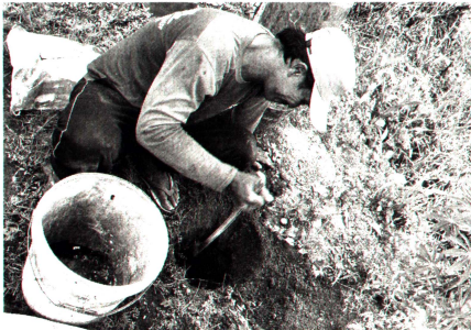
Warga Sorosutan membuat lubang resapan biopori.
