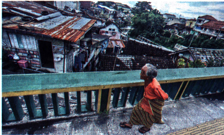
PERLU PENANGANAN: Warga melintasi Jembatan Gondolayu berlatar permukiman padat di kawasan Sungai Code, Cokrodiningratan, Jetis, Jogja, kemarin (20/3).
