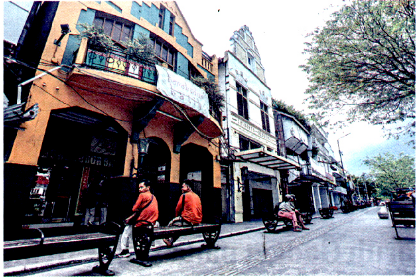
BELUM PUTIH: Deretan toko di kawasan Malioboro yang belum dicat putih kemarin (16/3). Kawasan Malioboro yang dilalui garis sumbu filosofi Jogja terus ditata. Fasad yang rencananya dikembalikan bentuk asli belum tampak hingga kini.
