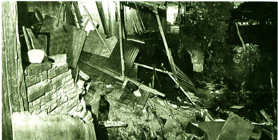
Kondisi bangunan yang terdampak longsor di Kelurahan Wirobrajan, Rabu (15/2).
