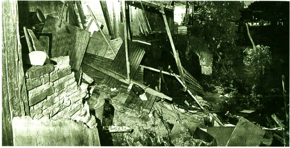
Kondisi bangunan yang terdampak longsor di Kelurahan Wirobrajan, Rabu (15/2).
