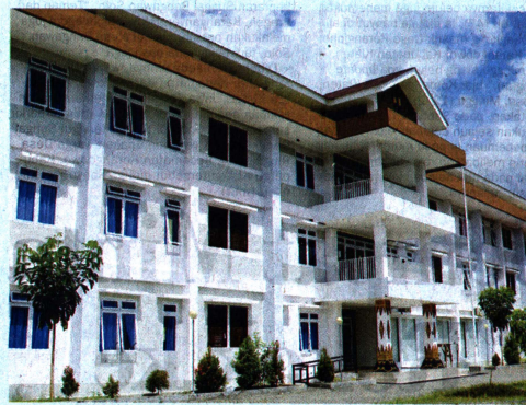
FASILITAS WARGA - Bangunan Tower 2 Rusunawa Bener Tegalarjo, Kota Yogya, yang saat ini sudah dihuni warga penyewa. Pemkot Yogya mengusulkan tambahan unit Rusunawa pada Kementerian Pekerjaan Umum dan Perumahan Rakyat (PUPR) RI untuk masyarakat berpenghasilan rendah
