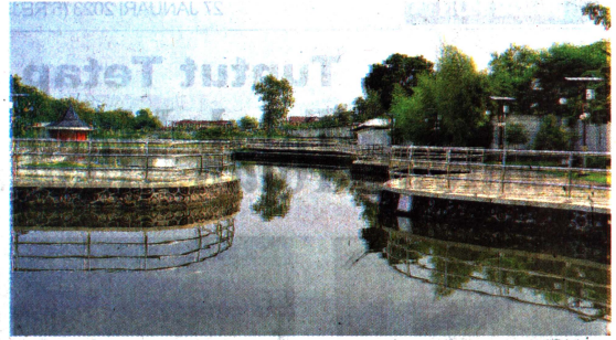
Taman Budaya Embung Giwangan yang siap dilanjutkan pembangunannya.
