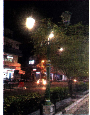
KR-Subchan Mustafa Sejumlah lampu penerangan jalan di sepanjang Jalan Margo Utomo Yogyakarta, mati. Tampak lampu yang mati di depan Kantor KR.
