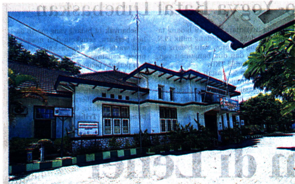
PRIORITAS PROYEK - Gedung SMP Negeri 8 Kota Yogyakarta yang masuk dalam prioritas revitalisasi oleh Pemkot setempat. Ada enam BCB yang nantinya akan direvitalisasi dengan Dana Keistimewaan (Danais).
