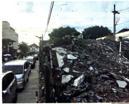
Bangunan bekas ruko yang dirobohkan di Jl. Perwakilan, Gedong Tengen, Joga, Senin (23/1). Kawasan itu akan dibangun taman sebagai bagian dari rencana pembangunan Jogja Planning Gallery.
