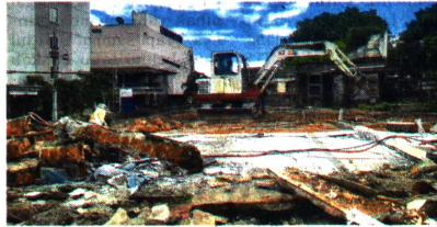
RATA TANAH - Sebuah alat berat melakukan pembongkaran ruko di Jalan Perwakilan, Minggu (22/1). Bangunan-bangunan di kawasan tersebut sudah rata dengan tanah setelah negosiasi alat antara pedagang dengan pemerintah Kota Yogyakarta.
