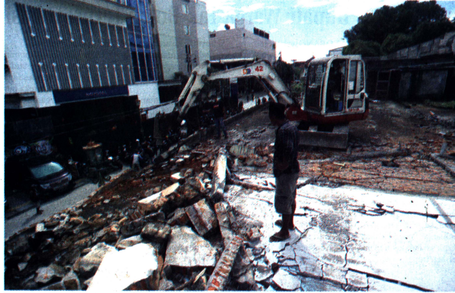
DIRATAKAN: Pekerja melakukan pembongkaran bangunan ruko di Jalan Perwakilan, Danurejan, Jogja, Minggu (22/1). Pembongkaran ruko sepanjang Jalan Perwakilan itu dilakukan mulai Sabtu (21/1) lalu. Pembongkaran dilakukan untuk melengkapi lahan Jogja Planning Gallery.
