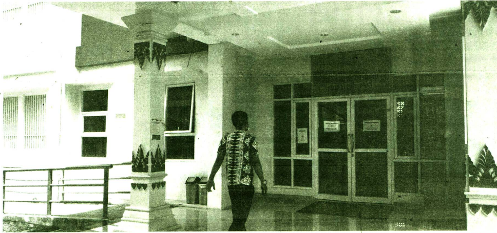
Suasana Tower 1 Rusunawa Bener yang rencananya akan difungsikan sebagai hunian warga setelah beberapa tahun terakhir jadi tempat penampungan pasien Covid-19 yang menjalani isolasi mandiri, Kamis (19/1).
