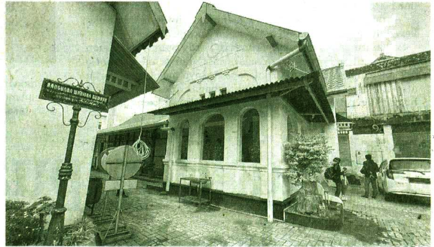
Bangunan cagar budaya di kompleks kantor Dinas Pendidikan Pemuda dan Olahraga Kota Yogyakarta yang baru saja direhabilitasi menggunakan dana keistimewaan 2022, Selasa (17/1/2023).
