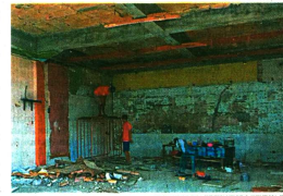
MANDIRI - Pedagang Jalan Perwakilan mulai membongkar kiosnya secara mandiri, Senin (16/1). Tidak hanya memindahkan kerangka bangunan dan menghimpun sejumlah material di dalam toko.
