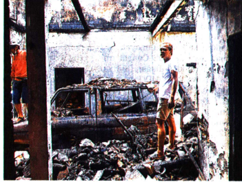
TRIBUNJOGJA/ MEPTAHUL HUDA KORSLETING Sebuah rumah di Jalan HOS Cokroaminoto terbakar, satu unit mobil hangus, Senin (12/12).
