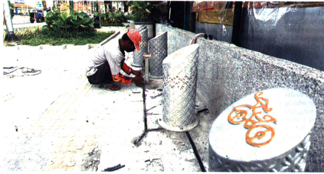
MAKIN CANTIK: Pekerja menyelesaikan pemasangan lampu hias di proyek pedestrian Jalan Panembahan Senopati, Kota Jogja, kemarin (12/12). Ditargetkan pengerjaan revitalisasi pedestrian Senopati-Titik Nol selesai sebelum libur Natal.
