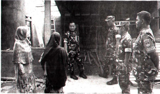
Danrem meninjau proses renovasi RTLH.
