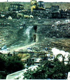
TAHAP LANJUT: Setelah TPS Transisi I selesai, tahun depan diwujudkan pembangunan TPS Transisi II dengan anggaran Rp 35 miliar dari APBD DIY TA 2023.
