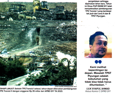
TAHAP LANJUT: Setelah TPS Transisi I selesai, tahun depan diresmikan pembangunan TPS Transisi II dengan anggaran Rp 35 miliar dari APBD DIY TA 2023.
