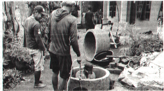
Pembangunan salah satu biopori yang dilakukan Kelurahan Gedongkiwo untuk mengatasi sampah organik.
