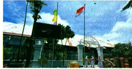
PERBAIKAN: Kondisi sekolah yang tengah direvitalisasi di SD Keputran 1 Yogyakarta, kemarin.
