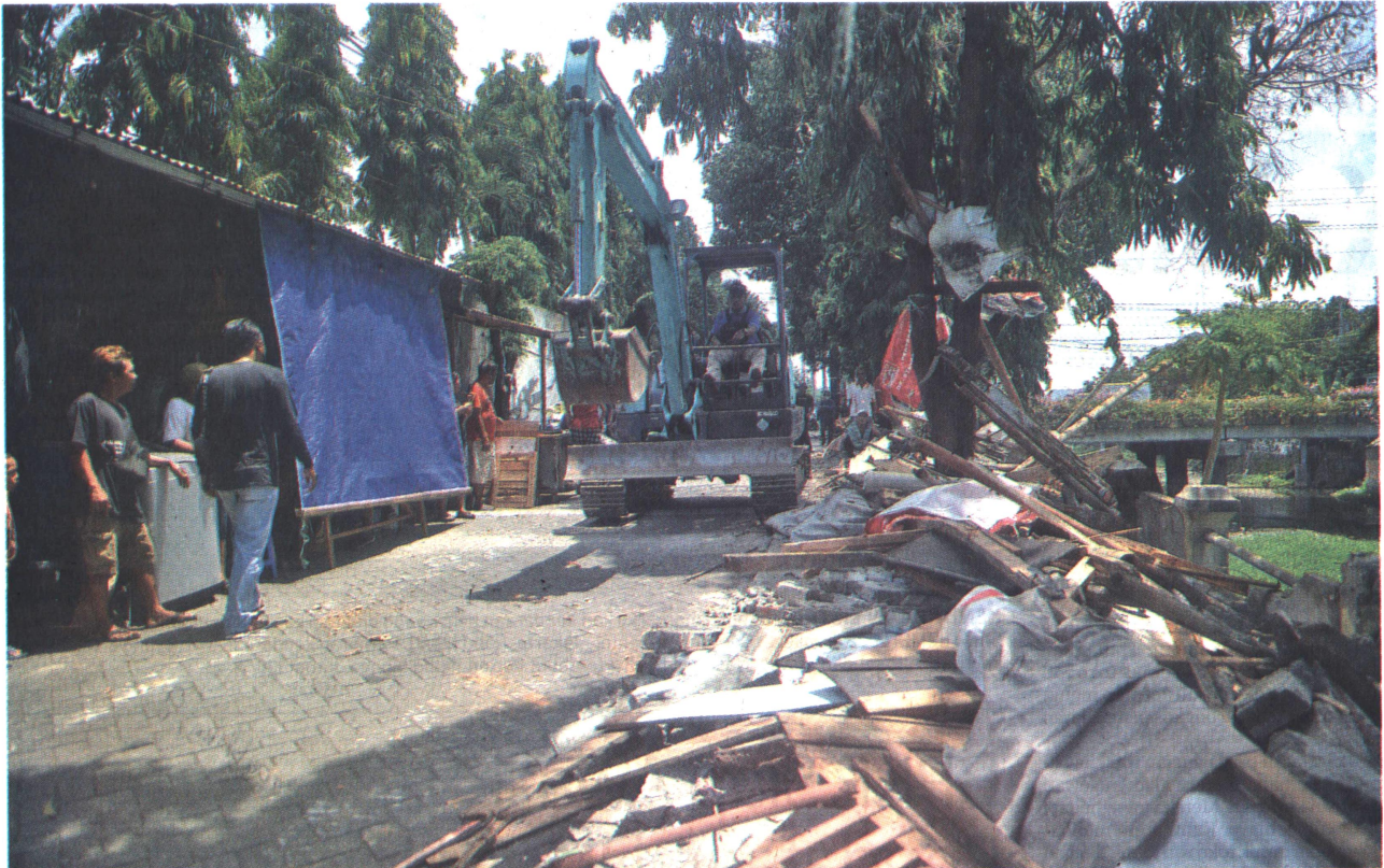
PEMBONGKARAN BANGUNAN DI SEMPADAN SUNGAI Alat berat membongkar bangunan tanpa izin di sempadan Sungai Code, Mergangsan, Yogyakarta, Rabu (28/9). Balai Besar Wilayah Sungai (BBWS) Serayu Opak akhirnya menertibkan bangunan tanpa izin di sempadan Sungai Code. Menurut peraturan bahwa area sempadan sungai merupakan area terlarang untuk mendirikan bangunan. Jumlah sisa bangunan yang dibongkar sebanyak 8 bangunan.
