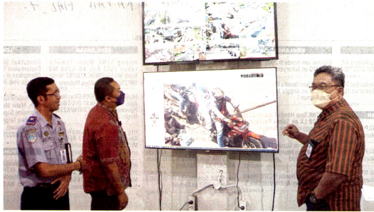
RUANG KONTROL: Sekda Kota Jogja Aman Yuridijaya (kanan) melakukan pengecekan di ruang kontrol pengaturan lalu lintas di kantor Dinas Perhubungan Kota Jogja, Kamis (1/9). Pemkot Jogja menargetkan dalam waktu tiga tahun ke depan semua simpang APILL bisa terhubung dengan sistem ATCS.
