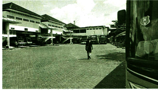
Terminal Giwangan Jogja yang kelak akan difungsikan sebagai tempat parkir bus wisata yang akan masuk ke Kota Jogja.
