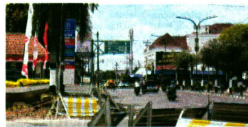
SUASANA: Simpang Gondomanan Yogyakarta akan menjadi simpang bebas kabel udara dengan ducting kabel listrik PLN dan fiber optic, kemarin.
