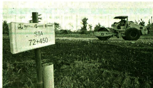
Operator mengoperasikan alat berat saat melakukan pengerasan tanah pada pembangunan Tol Yogyakarta-Bawen Seksi 1 di Seyegan, Sleman, Selasa (12/7).
