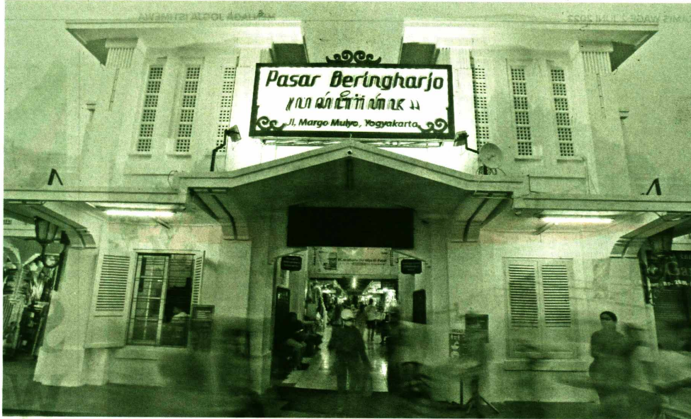
PERAWATAN: Pengunjung melintas di depan Pasar Beringharjo, Jogja, kemarin (1/6). Disdag Kota Jogja akan mengkaji ulang kekuatan bangunan pasar yang telah dua kali terdampak gempa.
