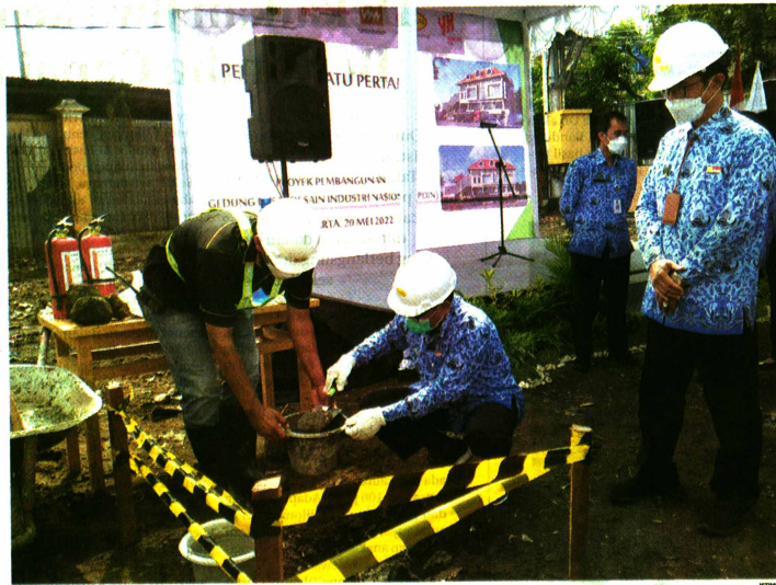
PROSES: Jajaran Pemerintah Kota Jogja saat meninjau dimulainya pembangunan gedung pusat desain industri nasional (PDIN) Jumat (20/5). maupun kualitas produk itu sendiri. Pendekatan yang dilakukan, lanjutnya, "Pemerintah dalam hal ini Disperinkop adalah dengan mengelola industri dari UKM Kota Jogja melalui PDIN akan mengelola dan mendampingi para pelaku kreatif dalam mengembangkan bisnisnya," ujarnya.
