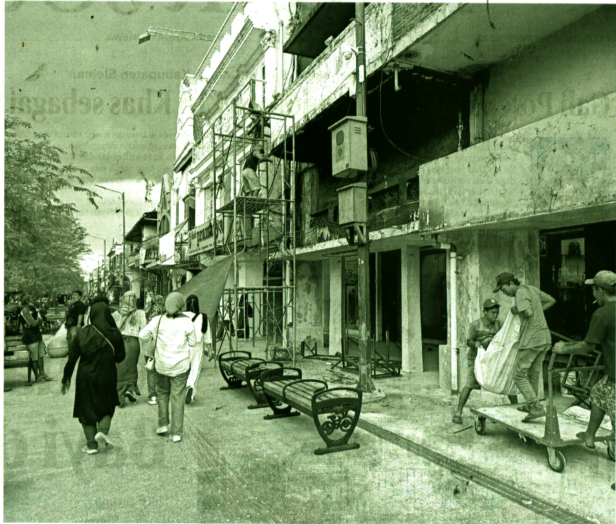
BERBENAH: Pekerja menyelesaikan proses renovasi bangunan toko di kawasan Malioboro, Kota Jogja, kemarin (17/2). Perbaikan dan penataan kawasan Malioboro tengah disebut termasuk fasad bangunan toko-toko.
