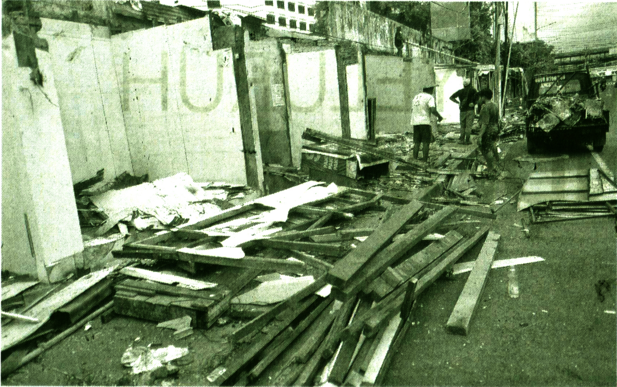
PEMBONGKARAN KIOS SEPATU YOGYAKARTA Pekerja membongkar bangunan kios sepatu di Jalan Mataram, Yogyakarta, Jumat (28/1). Pembongkaran kios sepatu ini untuk pembuatan akses masuk Teras Malioboro II di lahan eks Dinas Pariwisata Yogyakarta. Kios yang dibongkar juga mendapat jatah los di Teras Malioboro I.
