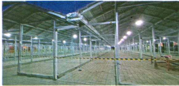
Lapak untuk relokasi PKL Malioboro di eks Gedung Dinas Pariwisata DIY.
