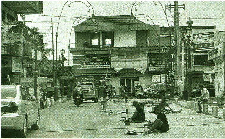
Perbaikan kerusakan di pedestrian Jalan Perwakilan Yogyakarta, Kamis (13/1).
