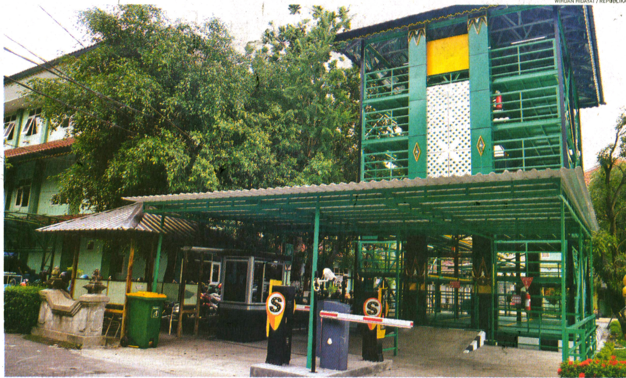
GEDUNG PARKIR BARU BALAIKOTA YOGYAKARTA Gedung parkir vertikal baru di Balaikota Yogyakarta, Rabu (11/1). Gedung parkir hidrolik ini memiliki kapasitas 200 sepeda motor. Biaya pembuatan tempat parkir ini sebesar Rp 2,3 miliar. Rencananya, tempat parkir ini akan digunakan pada Februari mendatang.
