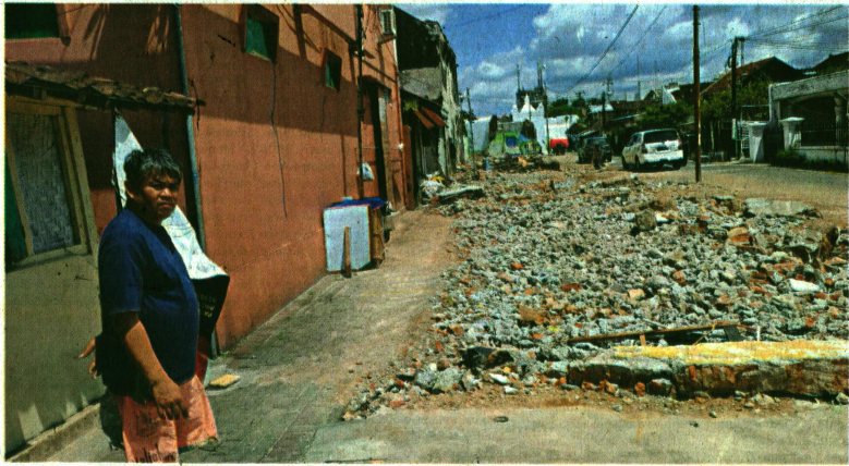
Warga berada di dekat bekas bangunan yang sudah dirobohkan di Jalan Kenekan, Yogyakarta, untuk dilakukan pembangunan kembali tembok Beteng hingga Plengkung Wijilan.
